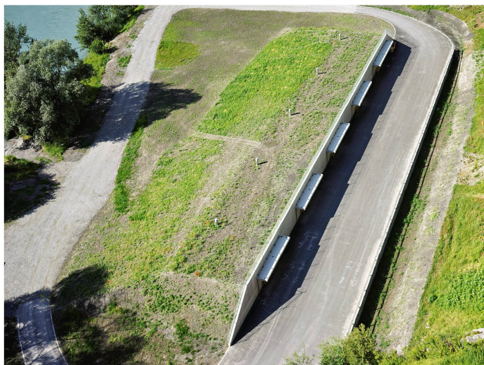
Der Prototyp des neuen Cuira-Munitionsmagazins steht seit 2017 in Haldenstein bei Chur. Bild: Armasuisse
