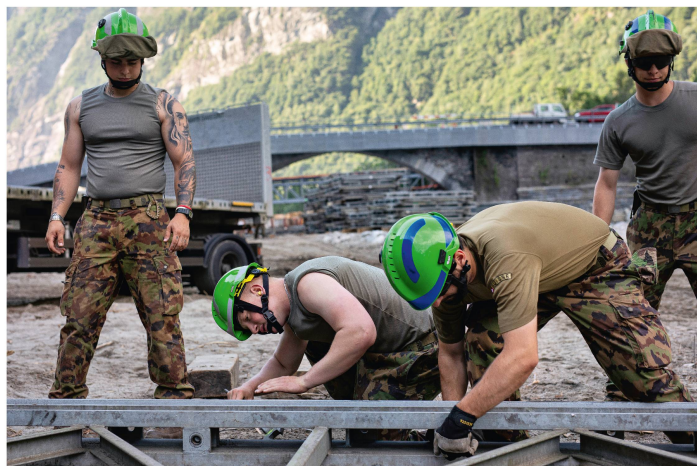
Armeeangehörige bauen Elemente für die Unterstützungsbrücke in Cevio im Maggital zusammen. Die Hauptbrücke wurde bei den Unwettern im Tessin Ende Juni zerstört. Bild: Dominic Wenger, VBS
