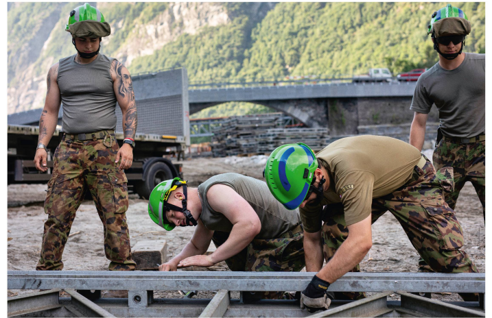
Armeeinghörige bauen Elemente für die Unterstützungsbrücke in Cevio im Maggiatal zusammen. Die Hauptbrücke wurde bei den Unwettern im Tessin Ende Juni zerstört. Bild: Dominic Wenger, VBS
