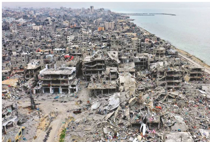
Grosse Zerstörung in Gaza. Bild: UNRWA
