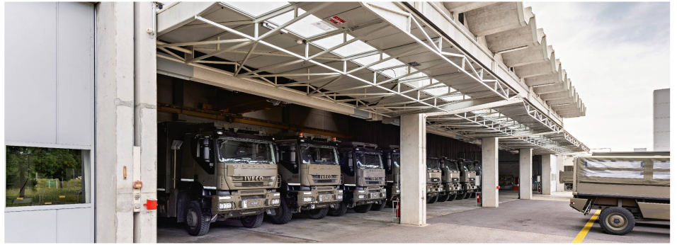
Bei den militärischen Immobilien besteht ein hoher Instandsetzungsbedarf. Bild: VBS
