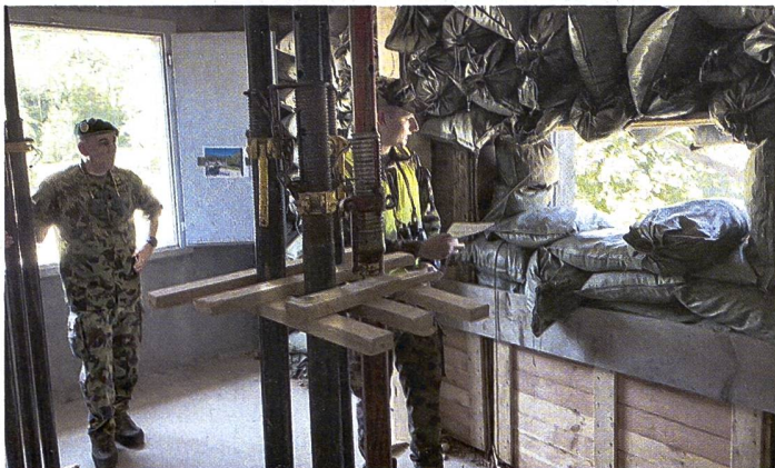
Die Häuserkampfanlage Stierliberg wurde zu einem Stützpunkt ausgebaut, wobei einzelne Häuser zusätzlich verstärkt und gehärtet wurden. Bild: cb
