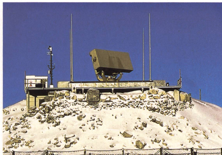
Diese Radarsensor-Anlage ist nun nach einer Modernisierung wieder im Einsatz. Bild: VBS
