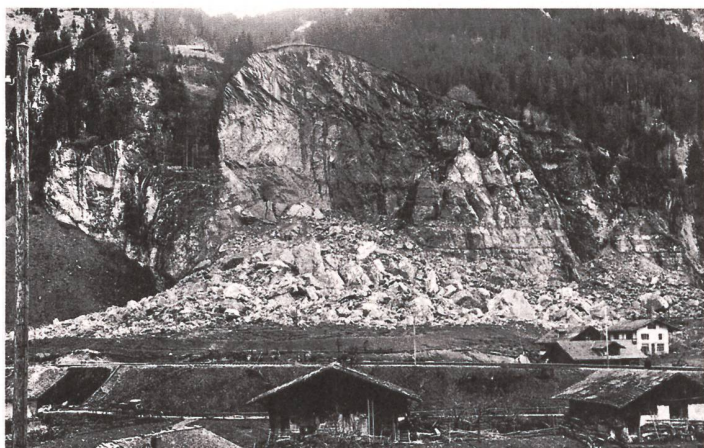
Trümmerlandschaft nach dem Explosionsunglück; abgebrochene Fluh, eingestürzter Bahntunnel.
