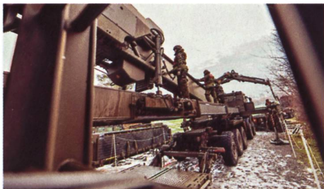
▲ Softwaregestützte Hydraulik, aber auch viel Sappeur-Manpower sind beim Ein- und Ausbau der 46 m langen Unterstützungsbrücke gefragt. Bild: Mech Br 4
