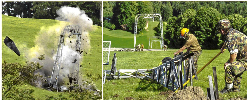
Das G Bat 23 sprengt Degersheim Skiliftmasten und Betonsockel. Bilder: Kdo Ter Div 4
