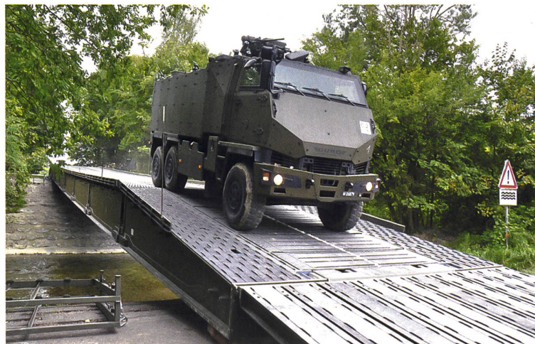
G Bat 23 erstellt zwei Unterstützungsbrücken über die Murg.
