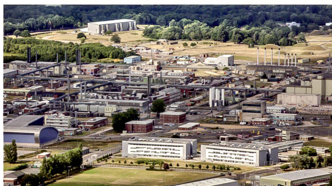
AWE Standort in Aldermaston, Südengland.
