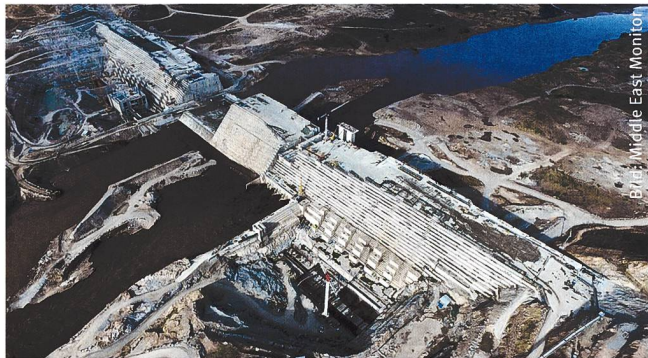
Am Fuss des Damms die beiden Maschinenhäuser im Bau.
