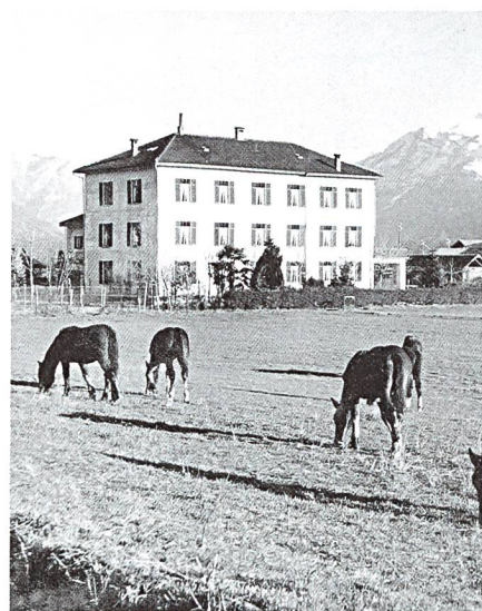
L'edificio principale dell'istituto di cura e di riqualificazione professionale di Tenero
