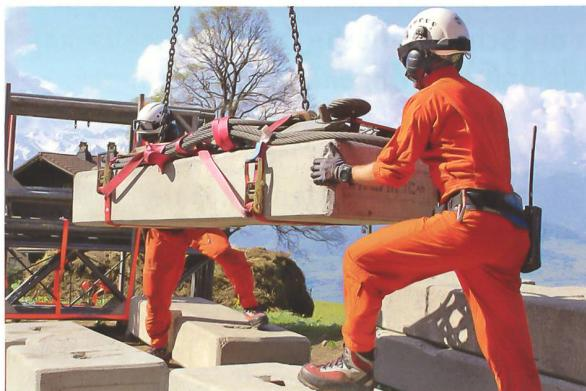
portverbänden absolviert werden. Höchste Präzision und Konzentration sind verlangt. Um sich gegenseitig fortlaufend zu entlasten, wechseln sich die beiden Piloten von Zeit zu Zeit am Steuer ab. In einer ersten Phase werden die sieben je 960 Kilogramm schweren Gewichtssteine geflogen – angehängt an einer 20 Meter langen Unterlastleine.
