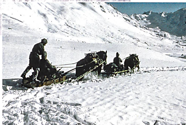
Der durch das Schauflerdetachment gebrochene und durch die Pferde gefestigte Ruttnerpfad wird anschliessend mit Schlitten trassiert.
