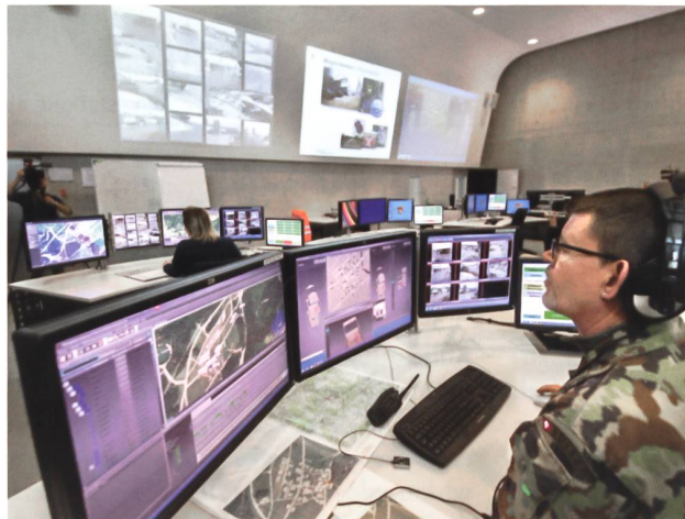
Blick in Leitzentrale.
