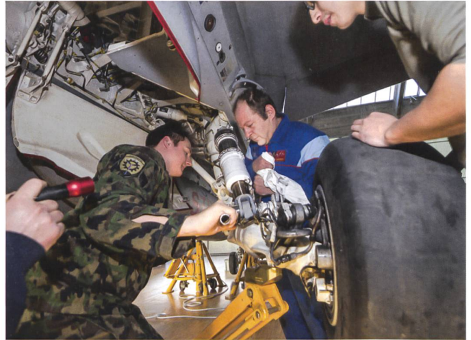
Miliz und Profis: In Sion unterstützen Flugzeugmechaniker AMHS (Aircraft Mechanic Hydraulic System) bei den Reparaturarbeiten eines F/A-18 Hornet.
