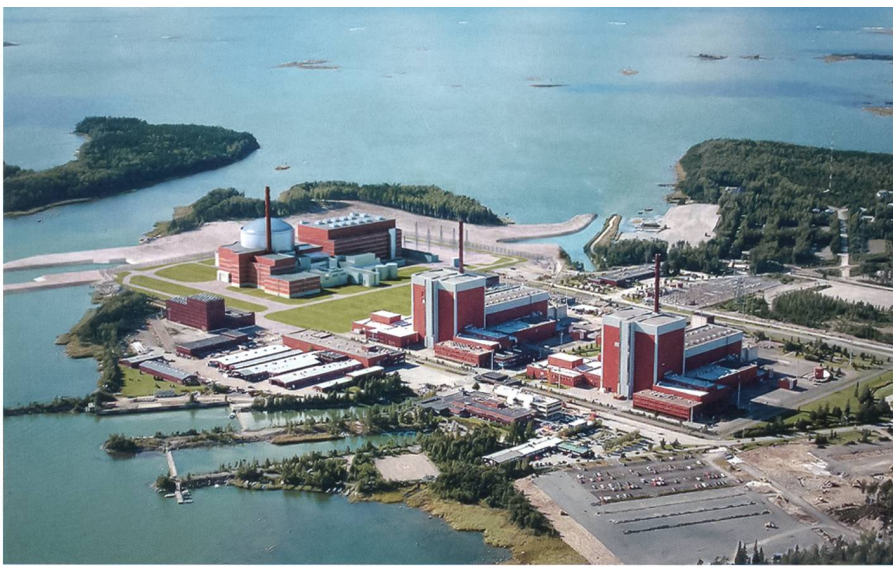
Fotomontage des in Bau befindlichen EPR (links im Bild) im Kernkraftwerk Olkiluoto, Finnland. Bild: Teollisuuden Voima OY
