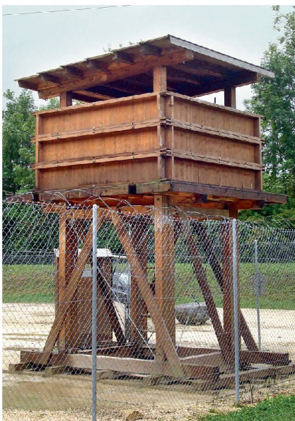
Abb. 3: Jede Einheit soll in der Lage sein, einen Wachturm aus Holz nach dem Baukastensystem selbständig erstellen zu können. Bild: LVb G/Rttg, W. Werder
