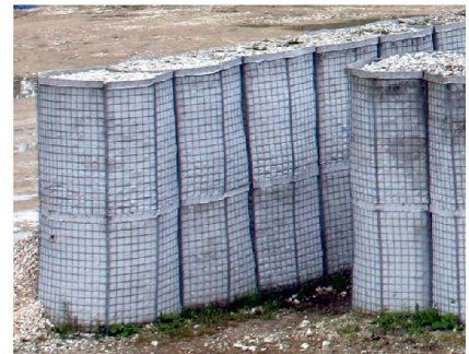
Abb. 4: Härtung einer militärischen Infrastruktur mit Schüttgutkörben.
