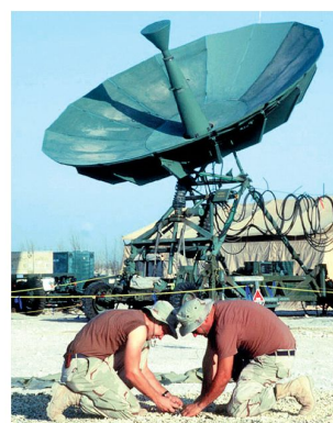
Antenne für Satellitenkommunikation in Afghanistan. Bild: ISAF
