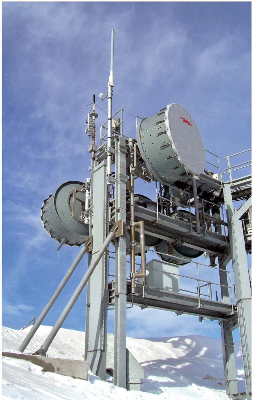
Link 16 Antenne auf einem Höhenstandort.
