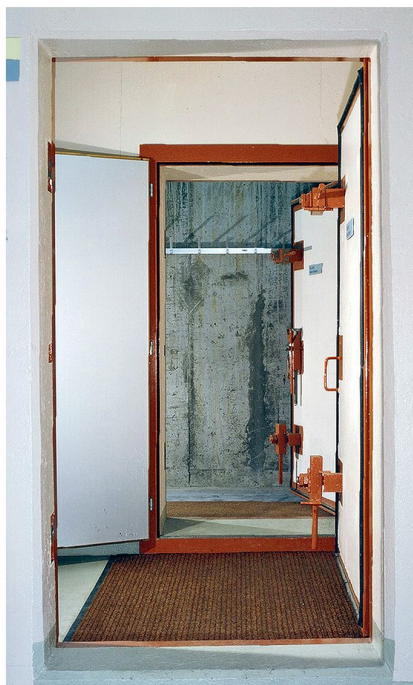
Schutzräume: Für den Krieg gebaut – und für mögliche Notfälle unersetzlich. Foto: BABS
