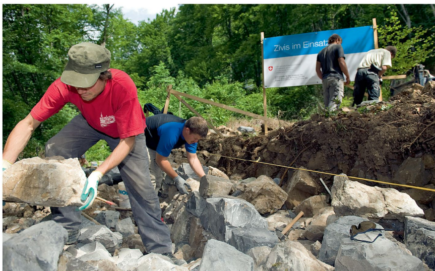
Zivildienstleistende beim Bau von Trockenmauern. Foto: P. Schneider, Thun
