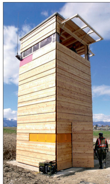
Die neuen Beobachtungstürme, mit modernster Technik ausgerüstet.
