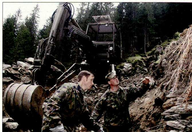
Lavori di consolidamento e di messa in sicurezza della strada.
