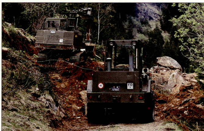
Sgombero e ripristino della strada forestale. Fotos: M. Morra
