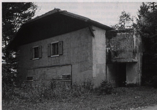
Pour la position de barrage de Lignerolle dans le Jura vaudois, le fortin «Les Rogets» fut camouflé en bâtisse civile. Bei der Sperrstelle Lignerolle, im Waadtländer Jura, wurde das Werk: «Les Rogets» als ziviles Gebäude getarnt.
