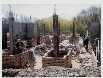
Eingangsbereich: Die tragende erdbebensichere Stahlkonstruktion wird mit Sichtmauerwerk aus in Kabul hergestellten gebrannten Backsteinen ummauert. Dazwischen kommt eine massive Schicht aus lokal hergestellten Lehmziegeln zur Wärmespeicherung (2005).
