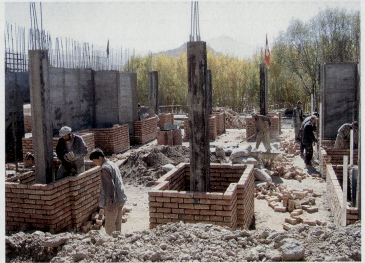
Eingangsbereich: Die tragende erdbebensichere Stahlkonstruktion wird mit Sichtmauerwerk aus in Kabul hergestellten gebrannten Backsteinen ummauert. Dazwischen kommt eine massive Schicht aus lokal hergestellten Lehmziegeln zur Wärmespeicherung (2005).
