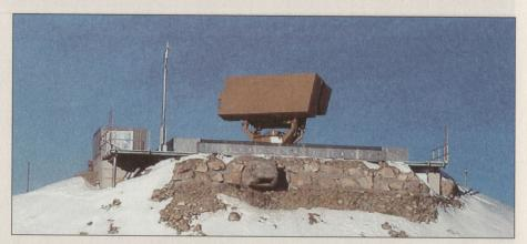
Das so genannte Advanced Radar kann nicht nur für die Rundumüberwachung, sondern auch ganz gezielt für die selektive Verfolgung zugewiesener Ziele eingesetzt werden. Es ist in der Lage, zugewiesene Ziele mit grosser Erneuerungsrate zu vermessen und dadurch die Flugwegbestimmung stark zu verbessern.
