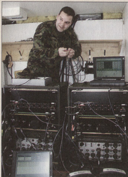
Installationsarbeiten. Foto: FU Basis
