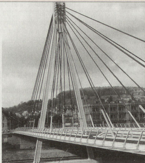
Projekt: Storchbrücke Winterthur Ingenieure: Höltsch + Schürter, Oerlikon
