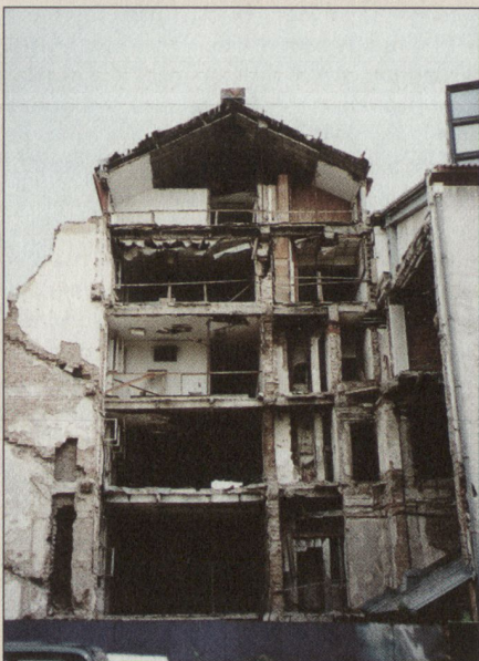
Zerstörtes Rundfunkgebäude in Belgrad.
