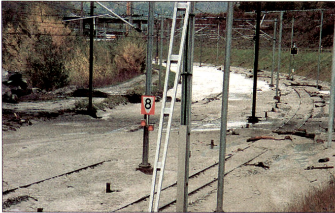
Schadenplatz Gamsen am 16. Oktober 2000.
