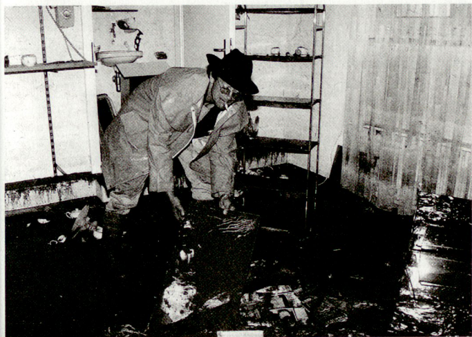
Hochwasserschaden im Wohnzimmer eines Wohnblocks an der Lettenmattstrasse in Birmensdorf ...
