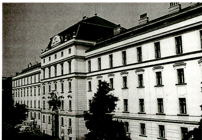
Das Amtsgebäude in Wien, in welchem die Landesverteidigungsakademie untergebracht ist.
