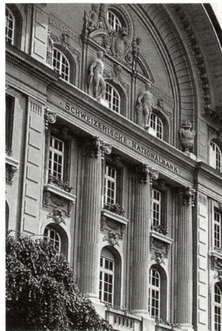
Ende 1995 betragen die Goldbestände der Nationalbank rund 12 Milliarden Franken.
