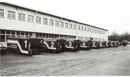
Für das Katastrophenhilferegiment wurden 3 Trägerfahrzeuge und 11 Wechselladebehälter (Welab) als Prototypausrüstung für ein Bataillon beschafft. (Welab 1: «Einsatzleitung», 2: «Chemie-/Strahlenschutz», 3: «Unterstützung», 4: «Beleuchtung/Strom», 5: «Wassertransport» [ $2 \times$ ], 6: «Brandeinsatz» [ $2 \times$ ], 7: «Überschwemmung», 8: «Umweltschutz», 9: «Sanitätsdienst». (BALST/KMV)
