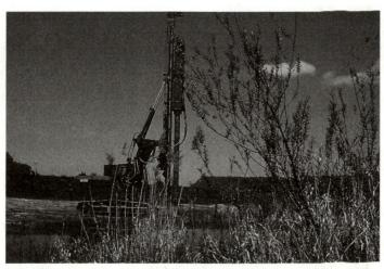
Abb. 3: Das Rammen von Pfählen (hier mit Ramme auf Raupenfahrgestell) als Voraussetzung zum Brückenbau. (Armeefotodienst)
