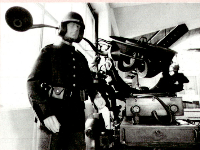
Einfaches Horchgerät für den Fliegerbeobachtungs- und Meldedienst (FLBMD): 1938 wurde die Erprobung von Horchgeräten für den FLBMD angeordnet. Aufgrund der Erprobungsergebnisse mit Scheinwerfern und Horchgeräten wurde aber entschieden, den FLBMD nicht mit Horchgeräten auszurüsten.
