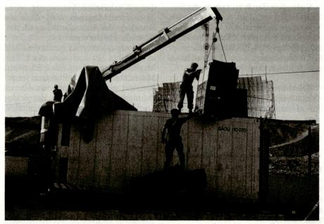
Aufbau der Klinik in Laâyoune. Die Inneneinrichtungen und das Material werden durch das Dach der Container gehievt.
