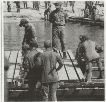
Griechische Pontoniere an der Arbeit: Die Metallfahrbahn wird auf eine Schwimmbrücke gesetzt. Im Hintergrund ein Steg im Bau.
