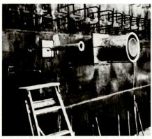
Abb. 5: Speziell konstruierte NEMP-Durchführungen bei einer Raumabschirmung
