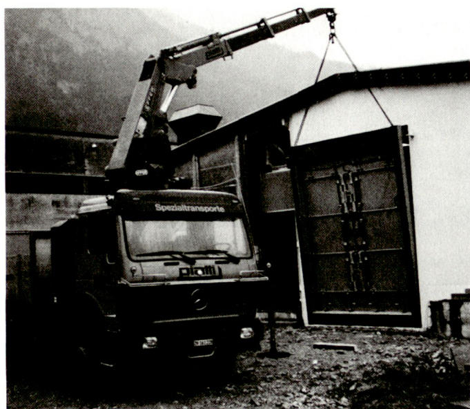
Abb. 6: Montage des NEMP-Tores einer oberirdischen, gegen NEMP von Hochexplosionen geschützten Anlage
