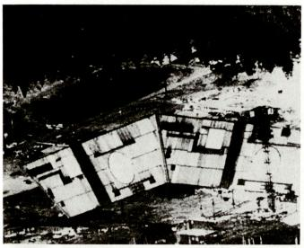
Der grosse Radar-Komplex PILL BOX mit Phased-Array-Antennen auf den vier Seiten einer Betonstruktur, in der Nähe von Puschkino, nördlich von Moskau; er stellt eines der neuen Elemente für die ABM-Abwehr der Hauptstadt dar.
