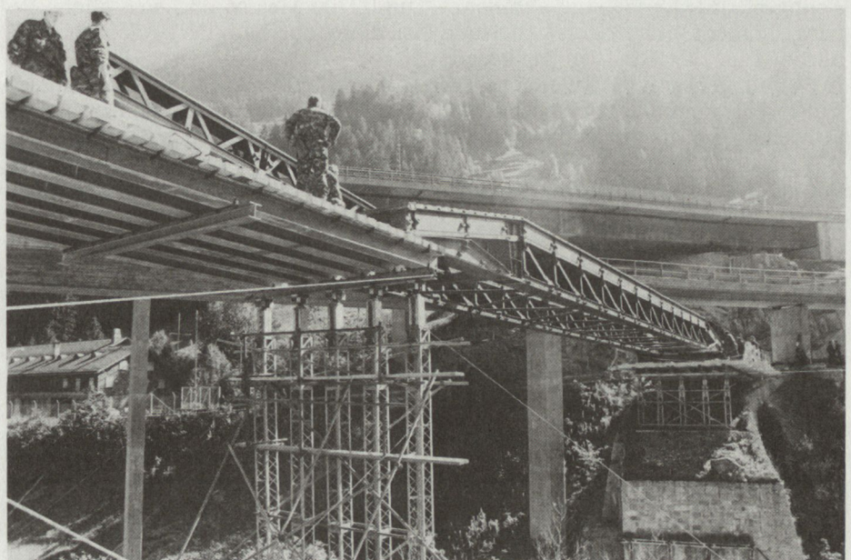
Genie. Brückenschlag bei Wassen.
