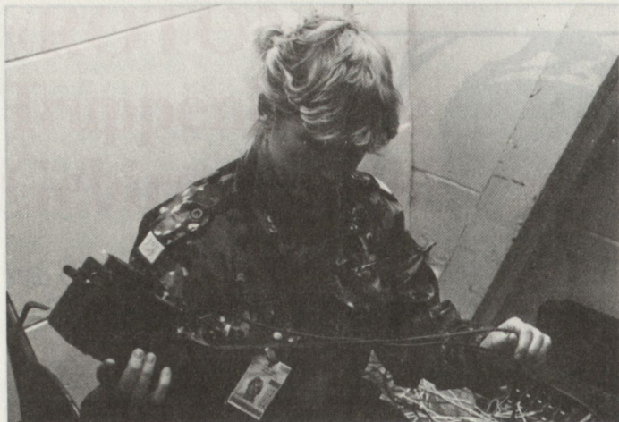
MFD-Übermittlungspionier beim Anschliessen eines Telefons.
