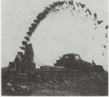
Grabenbagger MDK-2M auf Kettenfahrgestell AT-T. Dieser Bagger wird gegenwärtig durch MDK-3 abgelöst (Anmerkung Red.).
