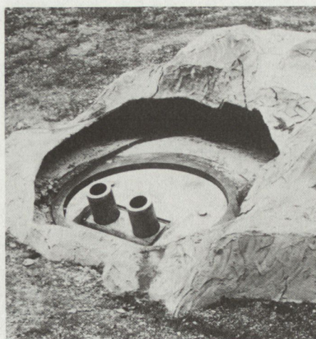
Rohrmündungen eines 12-cm-Festungsminenwerfers
