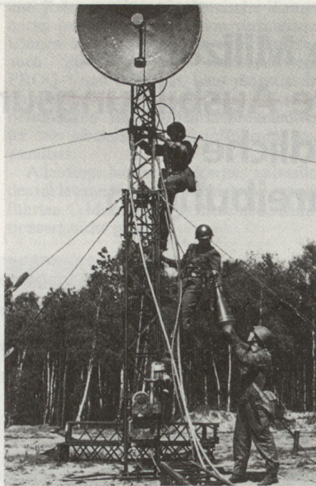
Aufbau einer sowjetischen Richtstrahlstation der 400er-Serie.
