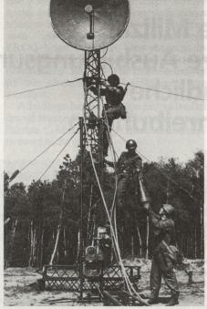
Aufbau einer sowjetischen Richtstrahlstation der 400er-Serie.
