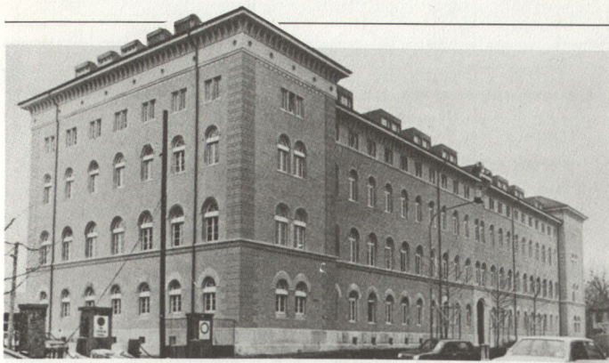
Die Aarauer Kaserne, gebaut 1848, nach der Gesamtrenovation im Frühjahr 1982. Die unter Heimatschutz stehende Fassade blieb unverändert...
