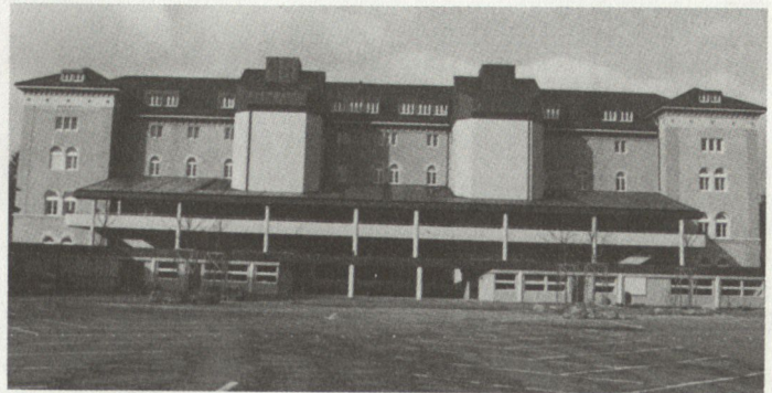
... während auf der Südseite (Kasernenhof) sogenannte Annexbauten mit Büros, Putzhallen und zwei Treppenhäusern die alten «WC-Türme» ersetzen.
