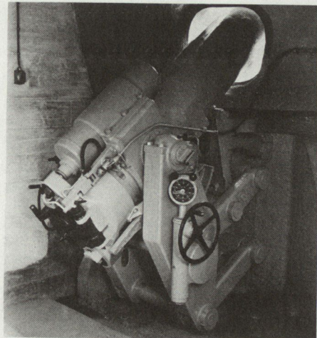
Bild 15. Geschützraum einer 15-cm-Kasemattkanone
