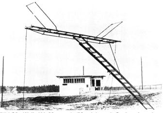
Bild 20. Weibel-Vo-Messgerät (Messleiter mit Spulenrahmen)
