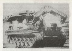
Einsatz stehenden IMR vorgesehen ist. Im Unterschied zum Vorgängersystem (Chassis T-54/55) basiert der neue Geniepanzer auf dem Fahrgestell des Kampfpanzers T-72.
